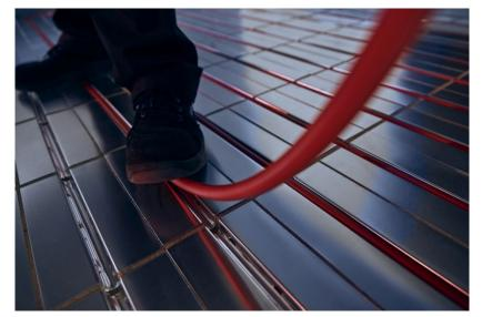
Ab Werk eingefräste Rillen, ausgekleidet mit Stahl- oder Aluminiumblechen, erleichtern die Rohrmontage und sorgen für eine optimale Wärmequerverteilung.
